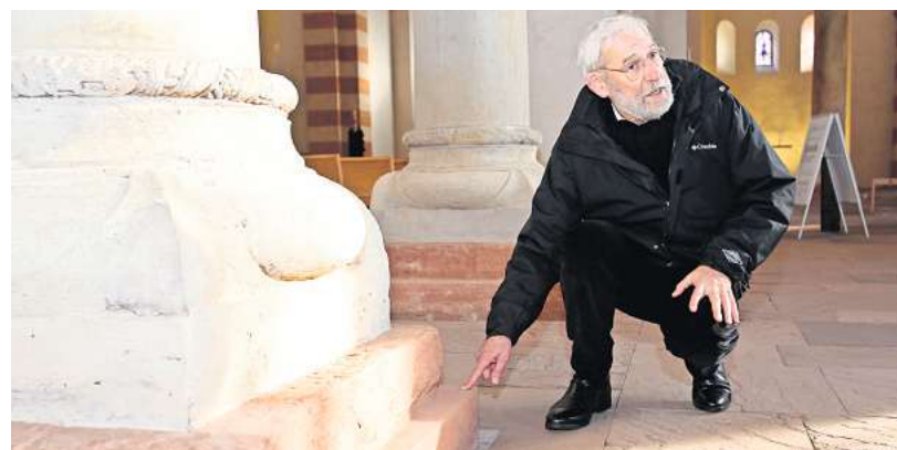
Der Stand jeder Säule ist mit vier Messpunkten fest definiert, sodass die Geodäten jede Veränderung ablesen können, erklärt Jürgen Götz.
